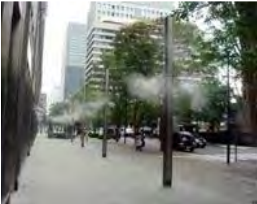
・ 仲通りのドライミスト発生装置
