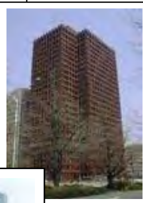
東京海上日動ビル （昭和 49 年）
