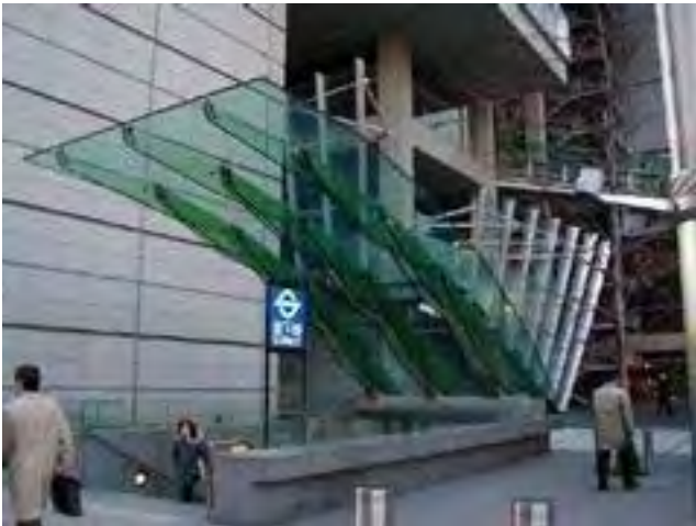
東京国際フォーラム 地下鉄出入口
