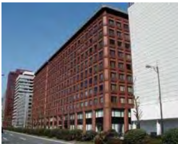
岸本ビル（手前）と丸ノ内三井ビル（奥）
