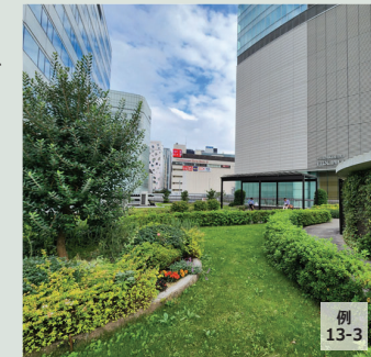
例 13-3 建物屋根面を覆う緑
