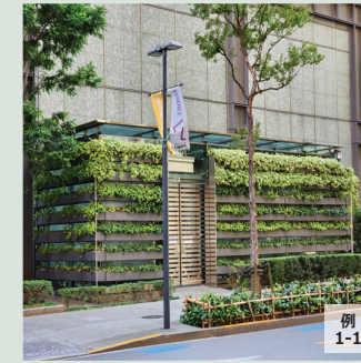
沿道の緑量感を高める壁面緑化 例 1-1
