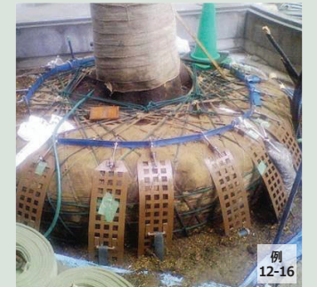
地下式支柱による風倒の予防
