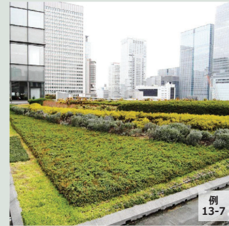
屋上緑化による雨水の一時貯留
