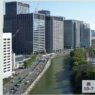
新築工事と併せた 漏水貯留浄化施設の整備
