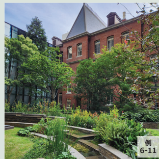
レンガ組構造と相性のよい植物を取り入れた一号館中庭
