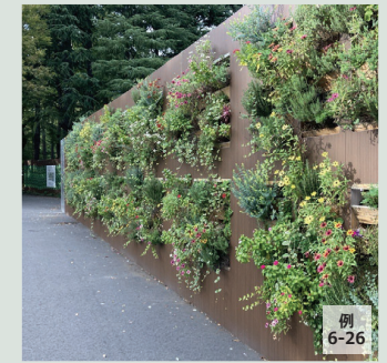
工事中仮囲いの壁面緑化
