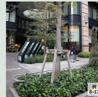
例 8-17 適切な樹木支柱の設置
